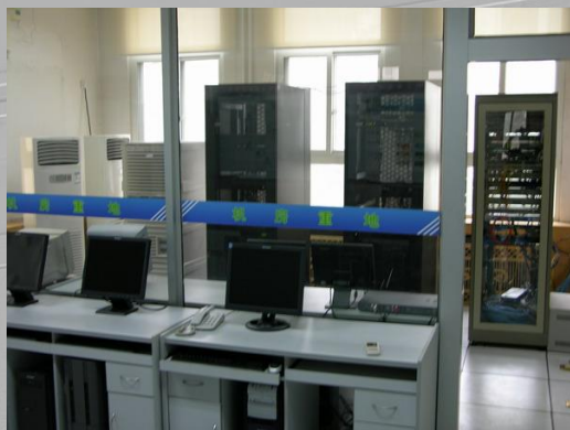
2005 年建成的图书馆机房（第二代图书馆数据中心）
