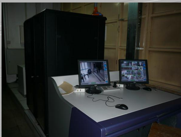
图书馆视频监控系统中控室。
