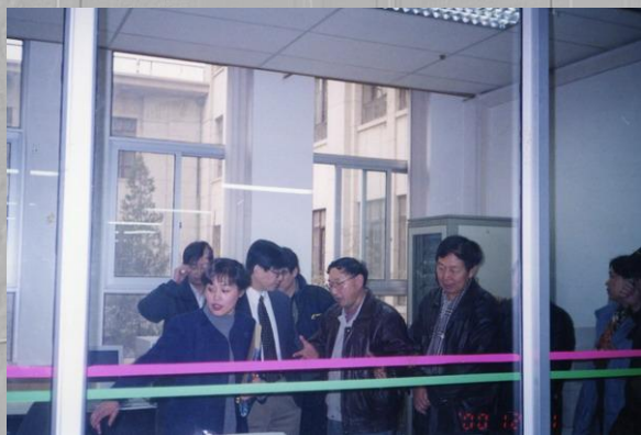
2000年的图书馆机房（图书馆最早的数据中心，现位于图书馆东楼201室）
