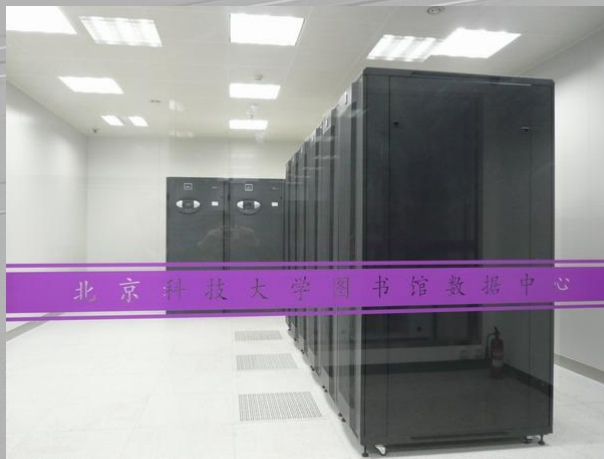
图书馆第三代数据中心
